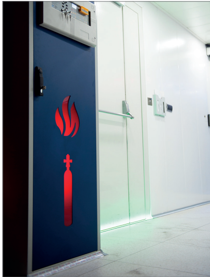
Konvansiyonel Yangın Algılama ve Söndürme Sistemi (FM200 ve NOVEC)
