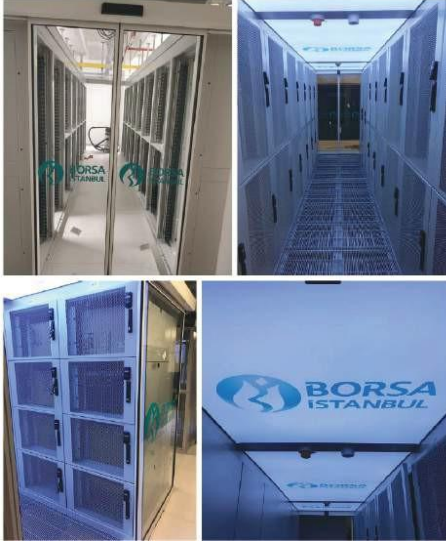
Borsa İstanbul – Barrisol Soğuk Koridor Kapatma Uygulaması
